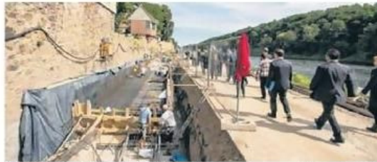
Flutschutz-Baustelle an der Mulde in Grimma.
